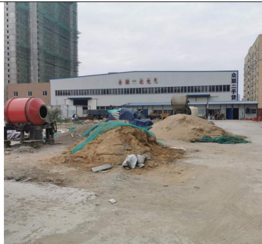
照片 2：施工生产生活区
