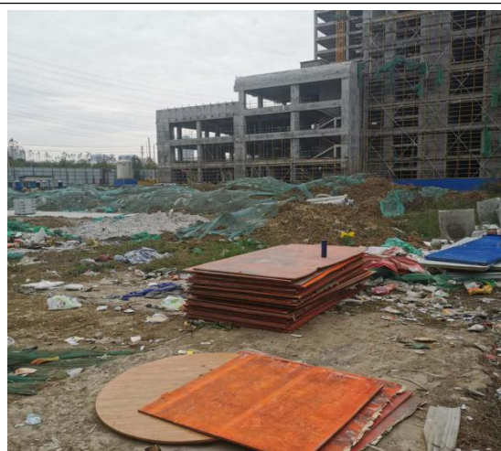
照片 1：主体工程区临时覆盖
